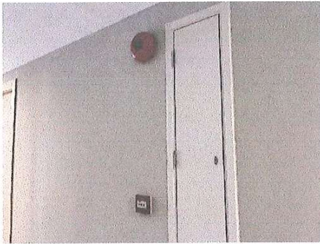
รูปที่ 49 กริ่งสัญญาณเตือนภัย (Alarm Bell)
