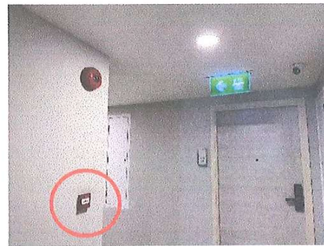
รูปที่ 48 เครื่องแจ้งเหตุโดยใช่มือดึง (Fire Alarm Manual Station)
