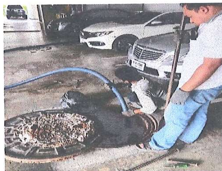
รูปที่ 12 รถสูบล้างสิ่งปฏิกูลเข้ามาสูบล้างไขมันและตะกอนส่วนเกินออกจากระบบบำบัดน้ำเสีย
