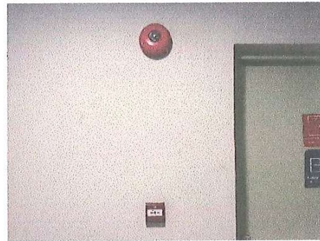
รูปที่ 49 กริ่งสัญญาณเตือนภัย (Alarm Bell)
