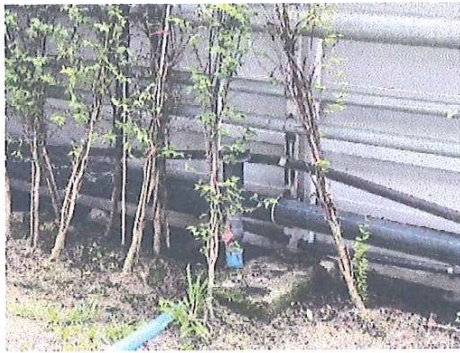
รูปที่ 32 ปอดินกำจัดมีเทนและละอองน้ำเสีย (Aerosol)
