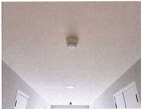
รูปที่ 47 เครื่องตรวจจับควัน (Smoke Detector)
