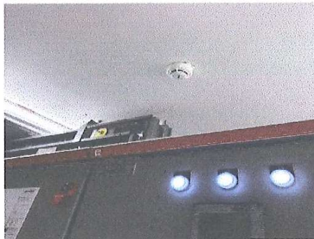
รูปที่ 29 เครื่องตรวจจับควัน (Smoke Detector) ภายในห้องเครื่องไฟฟ้า
