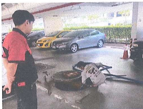
รูปที่ 12 รถสูบล้างสิ่งปฏิกูลเข้ามาสูบล้างไขมันและตะกอนส่วนเกินออกจากระบบบำบัดน้ำเสีย
