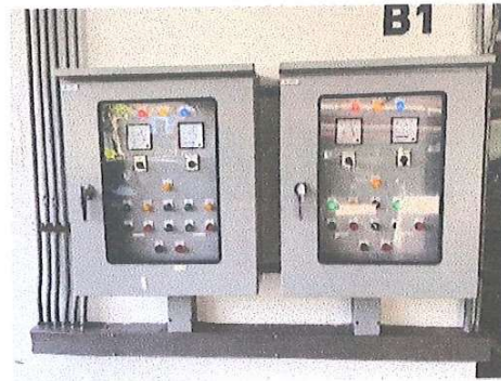
รูปที่ 13 ระบบมิเตอร์ไฟฟ้าสำหรับระบบบำบัดน้ำเสียของโครงการ
