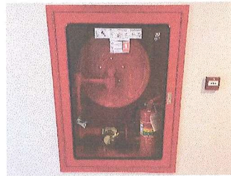
รูปที่ 34 ตู้เก็บอุปกรณ์ดับเพลิง
