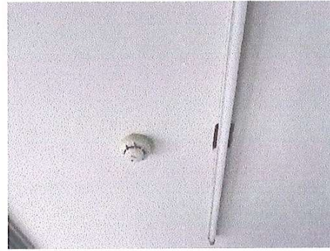
รูปที่ 47 เครื่องตรวจจับควัน (Smoke Detector)
